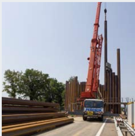
Pose de palplanches pour le pont sous l'A40 (commune de Saint-André-de-Bâgé)
