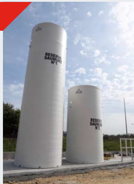
Citerne à saumure (commune de Mâcon)
