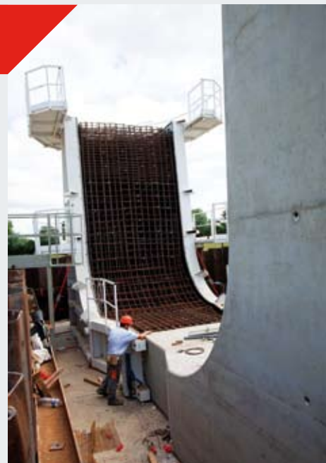
Des coffrages spécifiques ont été créés...
