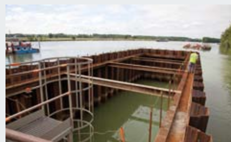
Un batardeau dans lequel sera coulée une pile en rivière.
