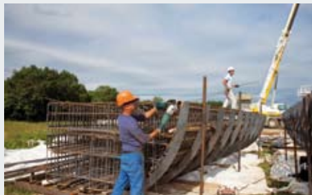
Assemblage du ferrailage des piles.
