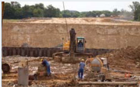
Le remblai d'accès au viaduc, d'où sera lancée la charpente métallique.
