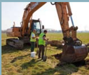
Découpage et prélèvement des plaques de terre avec un godet spécialement conçu.
