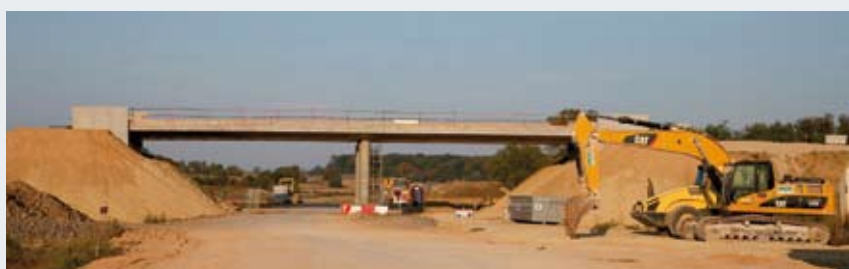
La RD933 où aboutissent les voies de la future gare de péage de Crottet sera rétablie avec la construction d'un pont passant au-dessus de l'A406.
