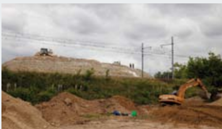
Pour passer au-dessus de la voie ferrée, il a fallu faire monter le remblai de l'A406 à 12 mètres de haut avant de construire le pont-route.
